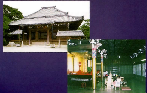
鋳葺 〔地藏院本堂（三重県亀山市）〕
